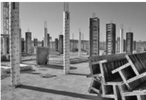
Los pilares son elementos de soporte o sostén de un edificio, de orientación vertical o casi vertical, destinados a recibir cargas (de compresión generalmente) para transmitir las a la cimentación y que tiene sección transversal poligonal (a diferencia de la columna que tiene sección circular). Otros elementos de soporte son muros y las columnas.
