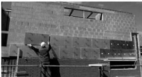
Todos los materiales oponen resistencia, en mayor o menor medida, al paso del calor a través de ellos. Los más utilizados son las lanas minerales (de roca y de vidrio) y las espumas derivadas del petróleo (poliestireno y polietileno expandidos).
