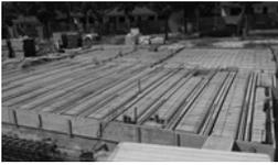
Elemento constructivo, horizontal o inclinado, formado por vigas y elementos de relleno que soportan su propio peso y las sobrecargas de uso. Su función es separar dos plantas.
