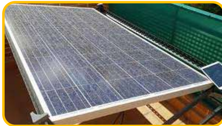
Panel que necesita una limpieza
