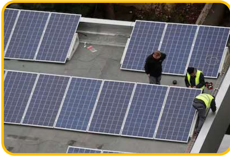
Operarios en placas fotovoltaicas
